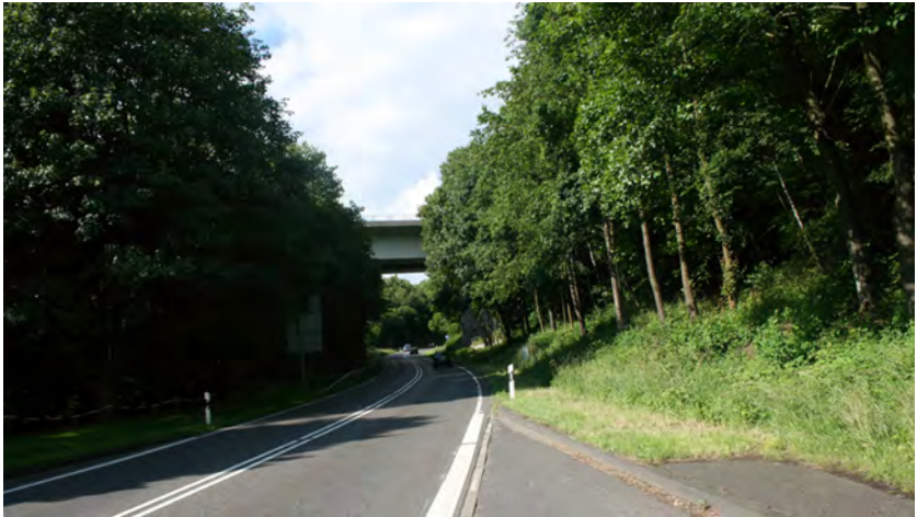
Abb. 3: Unterquerende Landesstraße L307 der Brexbachtalbrücke. Foto: P. SCHIEFENHÖVEL.
