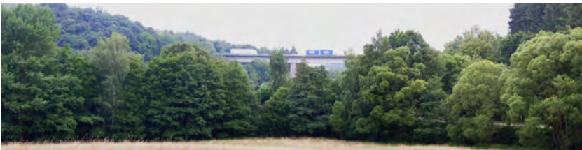
Abb. 2: Brexbachtalbrücke mit Blick von der Montabaure Höhe aus. Foto: P. SCHIEFENHÖVEL.
